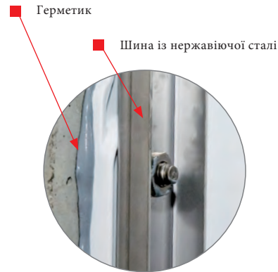
ACO Профікс» (герметик, який може набухати)
