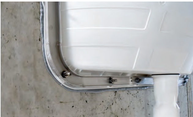
Монтажний комплект шин V2A ACO
