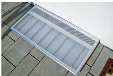
Кришка світлового приямку, який витримує пішохідне навантаження
