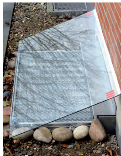
Кришка світлового приямку АСО із однокамерного броньованого скла ( G), включаючи обладнання для кріплення та стрічки для ущільнення.
