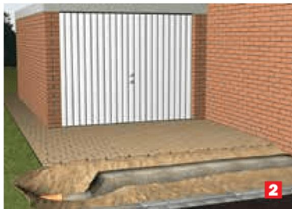
Каналы устанавливаются на основание из бетона марки В15 высотой 15 см и шириной 30 см.
