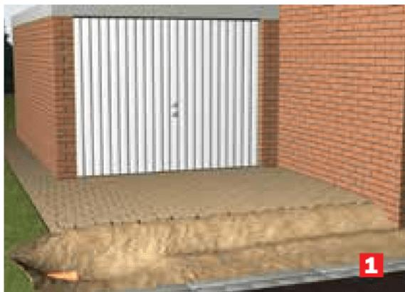
Выкопайте траншею и подведите трубу DN 100 для соединения каналов с ливневой канализацией.
