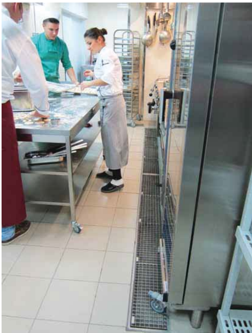
Профіль лоткового каналу 125.
