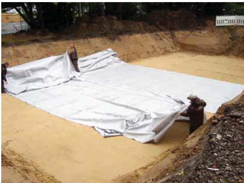
Монтаж дренажної системи ACO Stormbrixx схожий з монтажем накопичувальної системи. Всі етапи досить прості і не вимагають високої кваліфікації монтажників. Перед початком укладання системи необхідно підготувати котлован з горизонтальною (!), рівною і ретельно утрамбованою основою. При визначенні глибини котловану слід врахувати необхідну товщину шару ґрунту над системою ACO Stormbrixx для існування рослин (тонкий шар буде швидко випаровувати воду і рослини будуть гинути).
