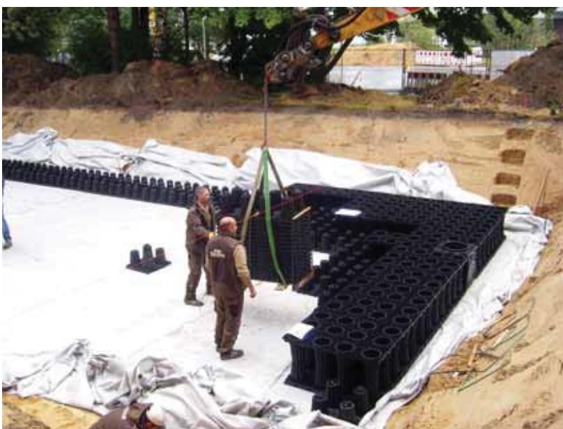
На наступному етапі проводиться укладання елементів ACO Stormbrixx з перев'язкою шарів (по аналогії з цегляною кладкою).
