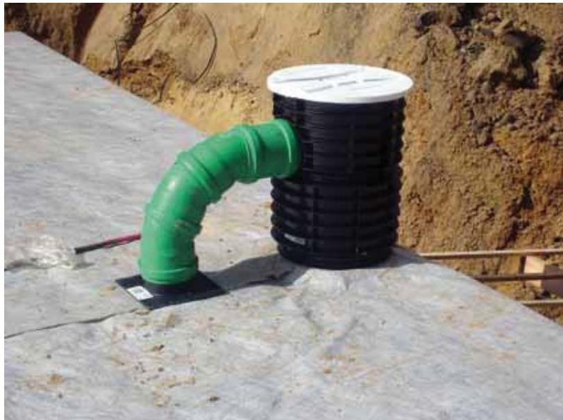
Після того, як виконано складання, ємність обертають в геотекстиль. Після монтажу всієї конструкції, встановлюються елементи ревізійної шахти і вентиляції.
