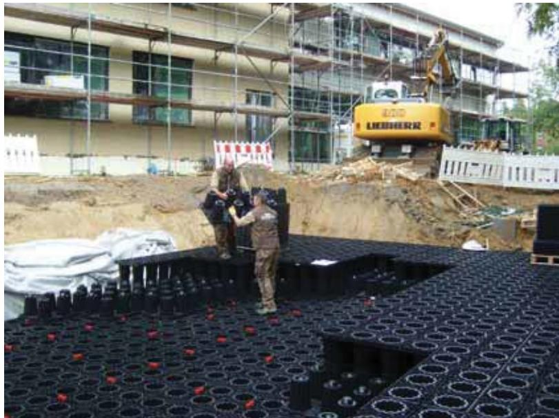
Після укладання верхніх частин блоків ACO Stormbrixx, проводиться їх фіксація між собою за допомогою з'єднувальної кліпси.
