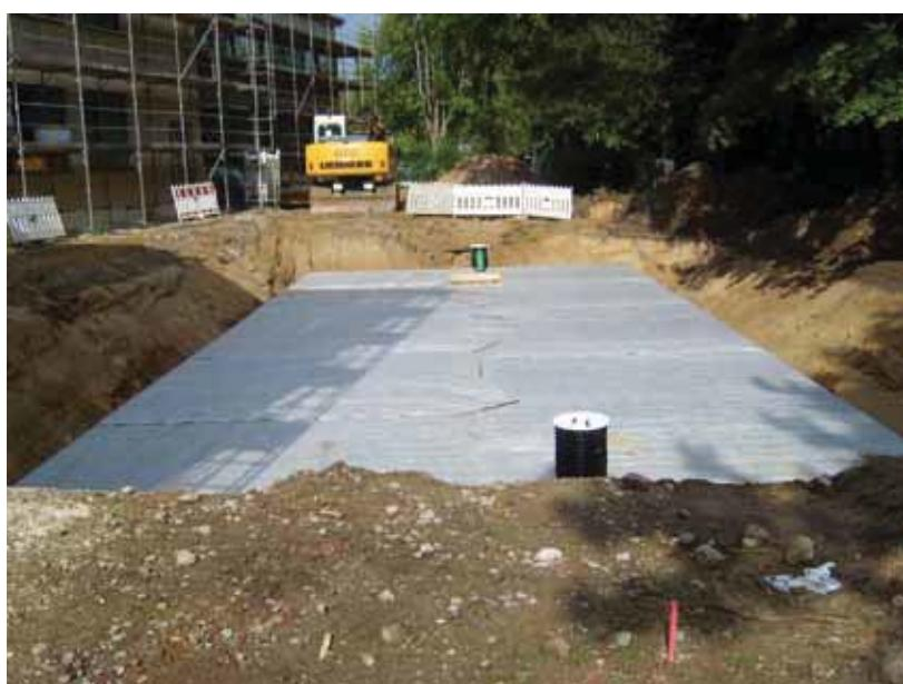
Виконується зворотна засипка ґрунту з ущільненням і укладається фінішне покриття.
