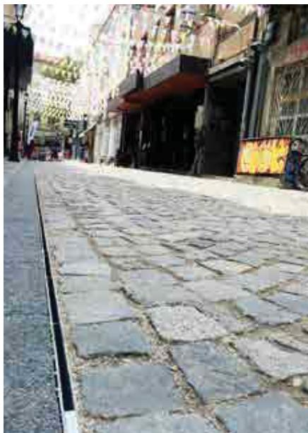
**ACO DRAIN® SlotTop Triple**
